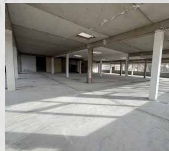
Büroumbau in der Pontarlierstraße, Villingen-Schwenningen
