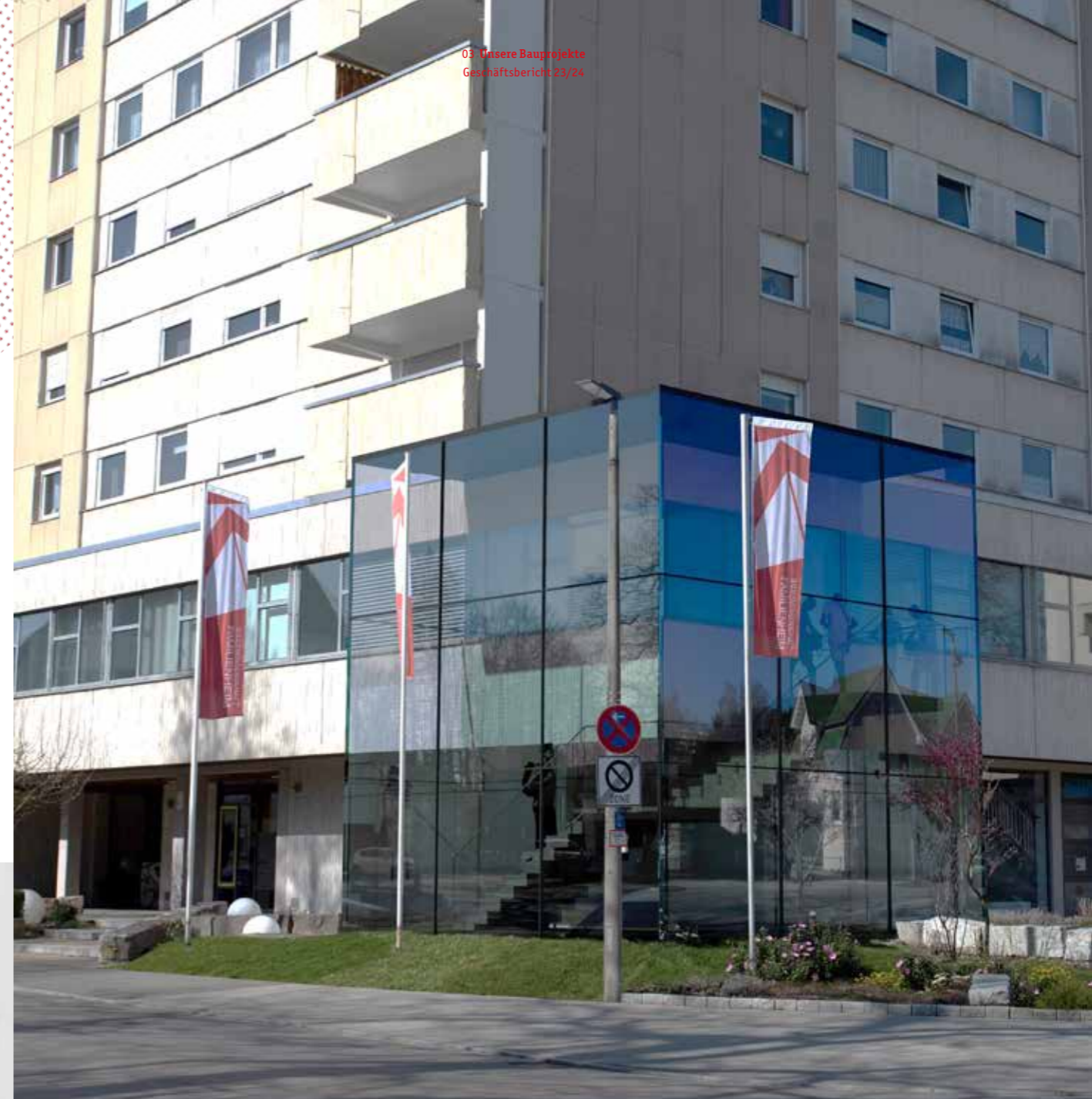
Die Büroräume erreicht man zukünftig über eine neu geschaffene Außentreppe
