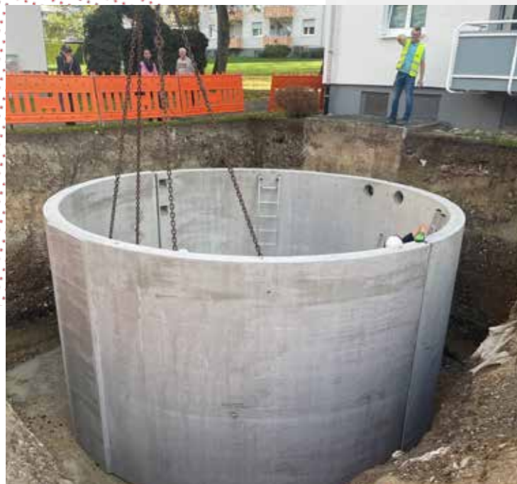
Pelletbunker im Fürstenbergring, Villingen-Schwenningen
