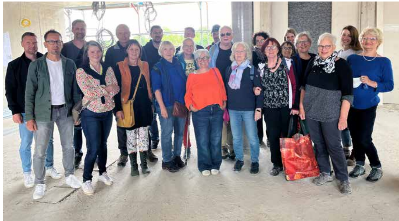
Die Wohngruppe »Palazzo« und Vertreter der Stiftung Liebenau bei der Baustellenbesichtigung in Tübingen.
