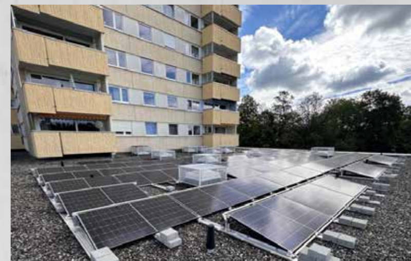
Installation einer PV-Anlage auf dem Bürodach
